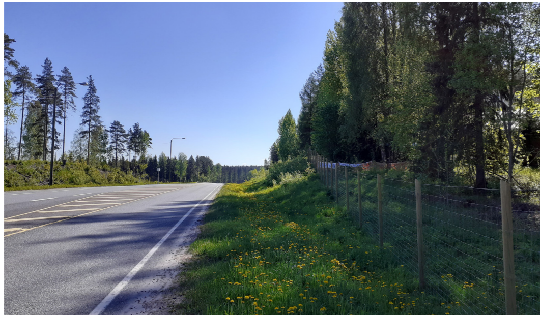
Kuva 4-11. Ensimmäisen vaiheen toimenpiteisiin kuuluu pohjavesisuojausten, ohituskaistan sekä jalankulku- ja pyöräilyväylän rakentaminen Kormun ja Silmänkannon väliselle osuudelle.
