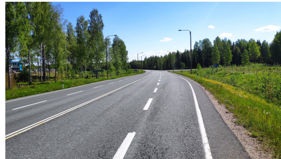
Kuva 4-4. Sipiläntien liittymäkulmaa tiukennetaan. Oikeallekääntymiskaista säilyy.
