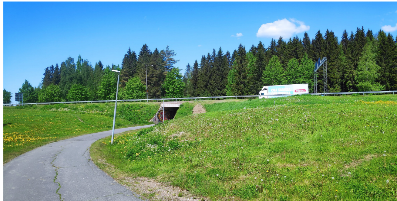
Kuva 4-6. Nykyinen Kirjauksen alikulkukäytävä kantatiellä 54 puretaan, ja jalankulku ja pyöräily ohjataan kantatien aliuuden sillan kautta.
